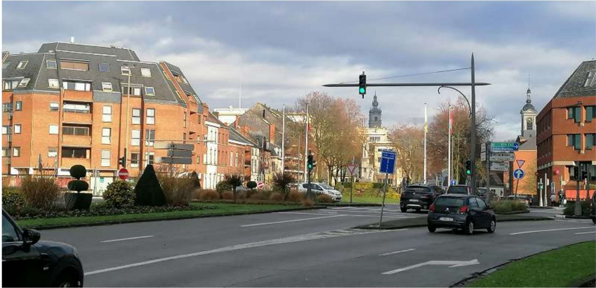
La place des Chasseurs à Pied vue depuis l'avenue de Gaulle, décembre 2023 Photo Gérard Waelput
